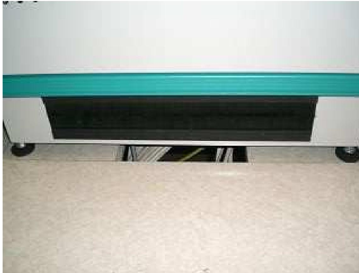
Drastische Luftdruckverringering im Doppelboden durch nicht abgedichtete Kabelöffnungen
