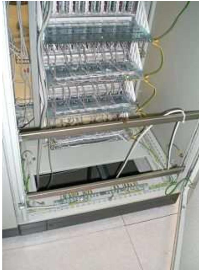
Ungewollte Kühlung passiver Komponenten durch überdimensionierte und nicht abgedichtete Kabelöffnung im Doppelboden.
