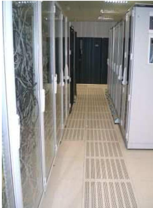
Hier werden geschlossene oder nicht vorhandene Serverschränke über falsch gesetzte Lochplatten mit Kaltluft versorgt
