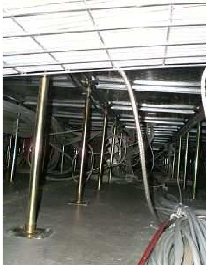
Behinderung des Kaltluftstromes über massive Kabelbäume im Doppelboden
