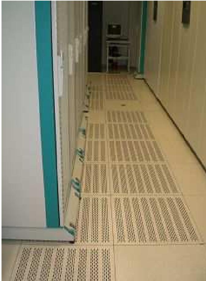
Über falsch gesetzte Lochplatten wird hier ein eigentlicher Warmgang gekühlt. Außerdem wird die Kaltluft ineffizient von unten in die Serverschränke geblasen.
