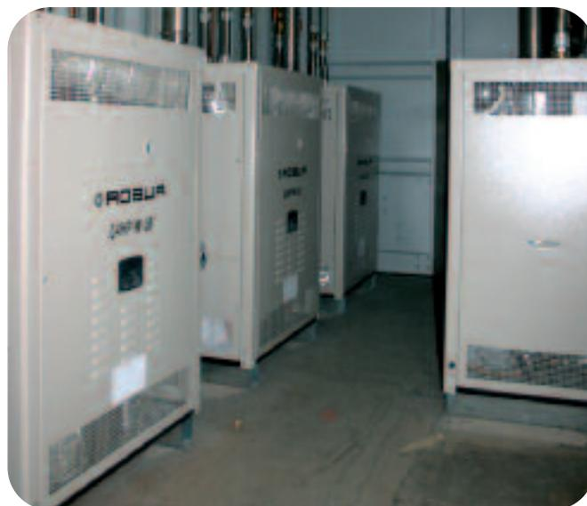
Realisiert wurde der Einbau von fünf Absorptionswärmepumpen vom Typ GAHP-W in einen Container. Die Gesamtheizleistung beträgt 194 kW, die Gesamtkühlleistung der Wärmepumpen beträgt 93,5 kW.
