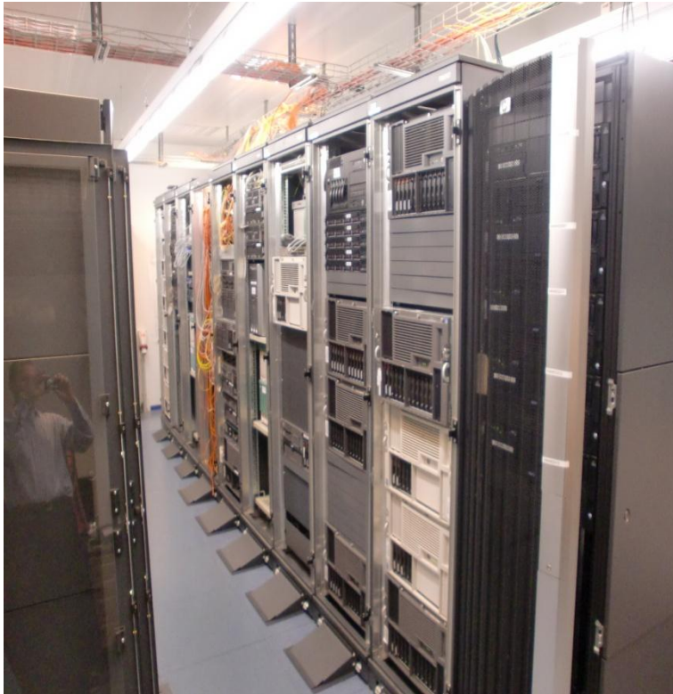
Kalte Rackseite (Front)
