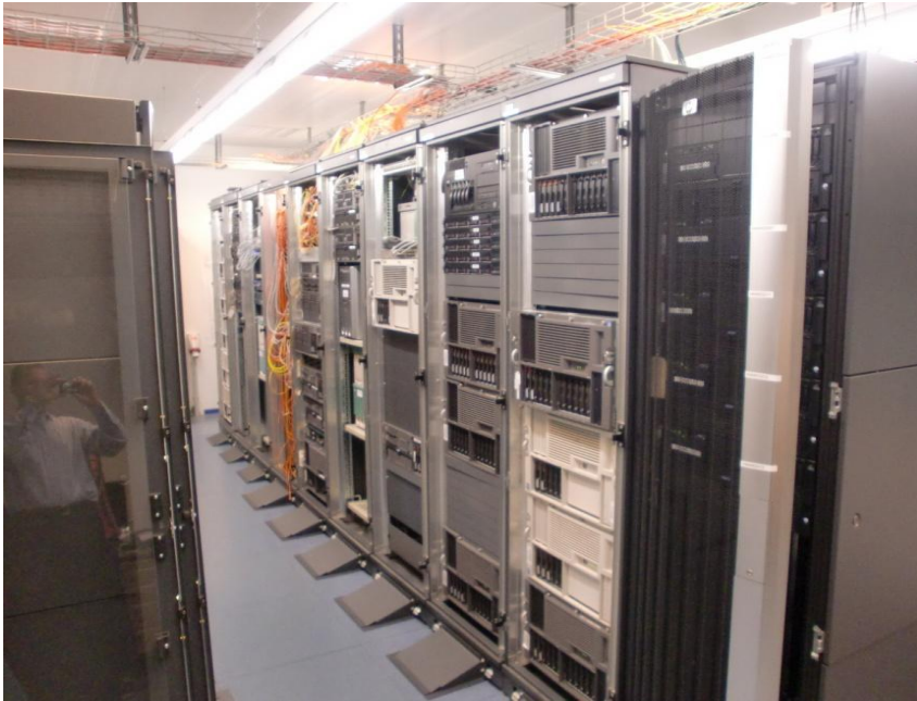
Kalte Rackseite (Front)
