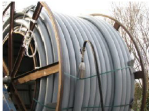
Abbildung 2: Befüllung der Sonde mit Wasser
