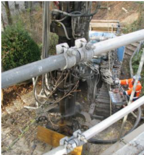
Abbildung 1: Erstellung des Bohrlochs
