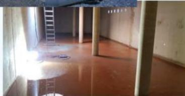
Unterstützende Säulen können aus Gründen der Baustatik vorgesehen werden und stellen Befestigungsmöglichkeiten für die Rahmenkonstruktion der Wärmeübertrager dar.
