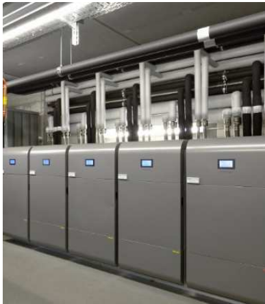
Serverraumkühlung mit einer KWKK Anlage im Sohnix Rechenzentrum Rostock
