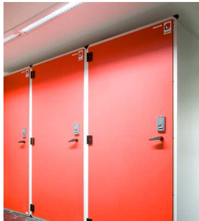
Wassergekühlte Serverschränke im Rathaus Marburg
