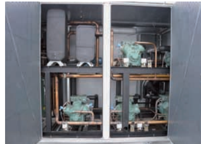
Kompakt, zentral und hocheffizient: Verbundkälteanlage bei LSG Sky Chefs.
