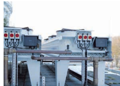
Herzstück für freie Kühlung: Außenluftkühler bei der TK.
